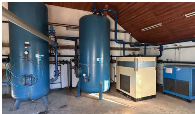
Sušilnica komprimiranega zraka
